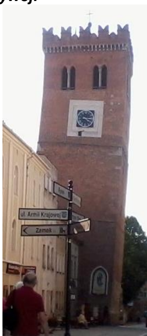
Odchylenie wieży od pionu – 2.14 m
