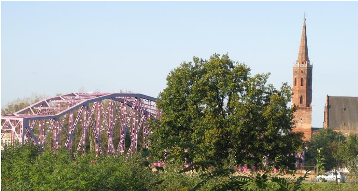
Odremontowana kolegiata, most i inne obiekty
