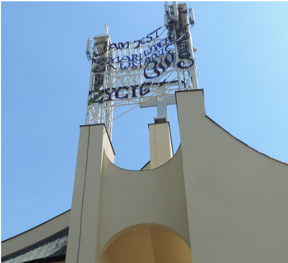
Fasada kaplicy od ul. Bardzkiej
