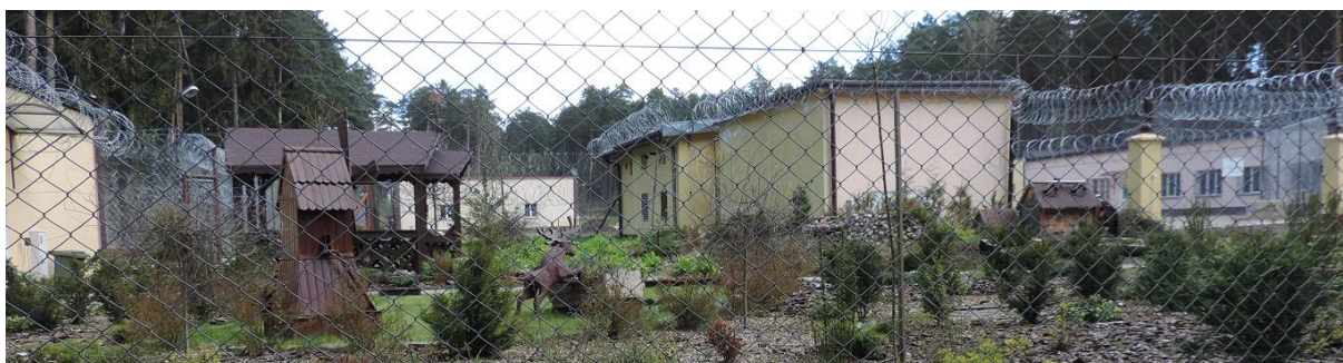
Pomieszczenia aresztu śledczego
