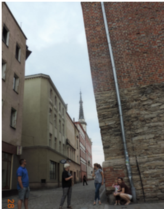
Krzywa wieża /34 m wysokości. Odchylenie od pionu – 214 cm. Grubość murów >4m./ W głębi ratusz
