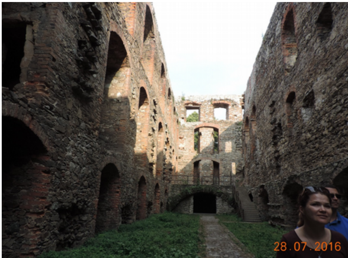
Odbudowane i wzmocnione elementy murów
