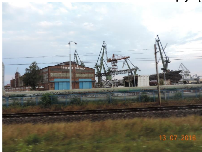
Widok na Stocznnię Gdańską – smutek ogarnia
